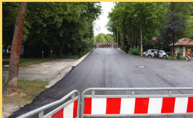
09.08.: Die Umleitung über die Glems braucht noch etwas
