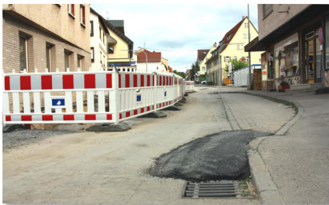
An der Engstelle wird/bleibt es eng nach Freigabe einer Fahrspur
