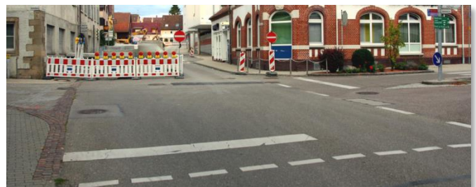
Die Arbeiten an der Bahnhofstraßen-Kreuzung beginnen später
