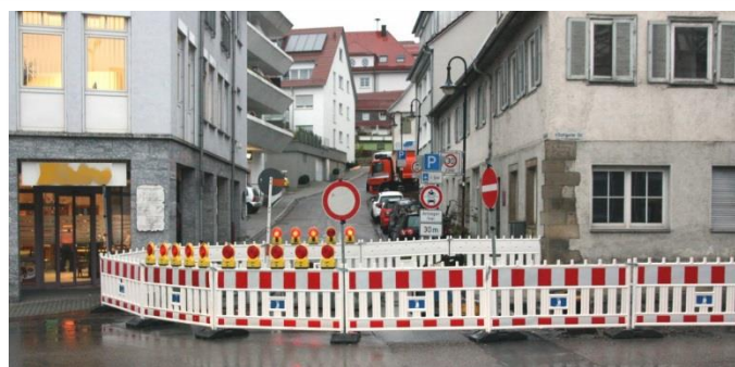
Die Baustelle ist an der Bahnhofstraßenkreuzung angekommen.
