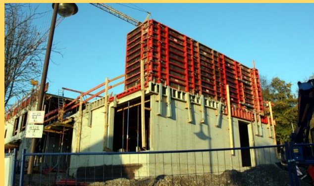
Eine der letzten Wandverschalungen, südlicher Gebäudeteil
