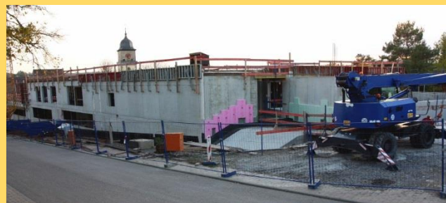
Blick auf den Neubau: Die finale Geschosshöhe ist erreicht
