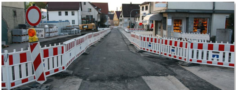
Neuer Asphalt: Durchfahrt ausschließlich für Anlieger frei
