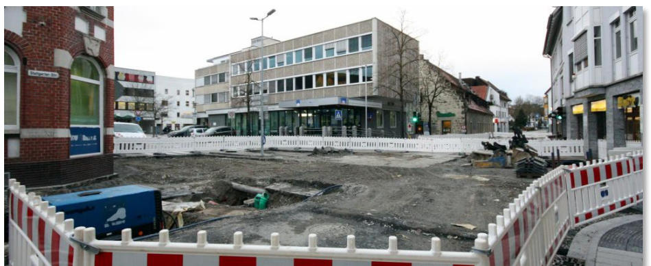
Die Bahnhofstraßenkreuzung – Bauschwerpunkt der nächsten 2 Wochen
