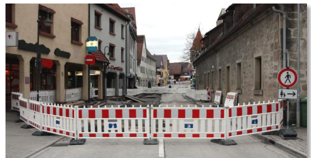
Vollsperrung in der Vaihinger Straße
