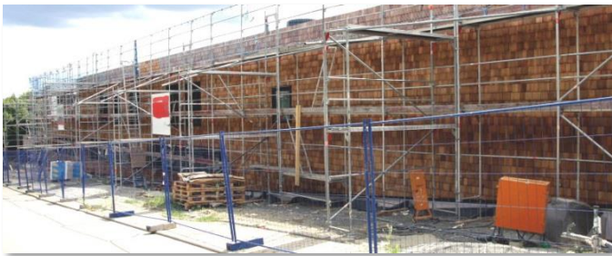
22.06.2018: Hinter dem Gerüst wächst die Holzverkleidung
