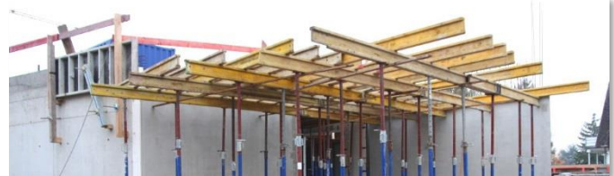
Oben: 19.06.2017: Als der Bagger noch am Werk war Mitte: 17.11.2017: Rohbau in vollen Zügen (Eingangsportal) Unten: 23.11.2018: Das fertige Gebäude mit Parkplätzen
