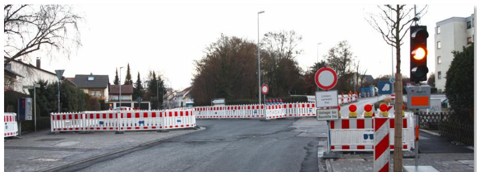
14.01.2019: Ein aktueller Blick auf die Baustelle mit neuer Baustellenampel
