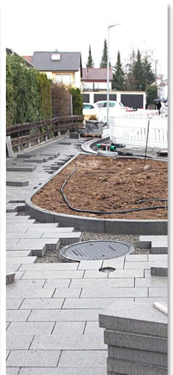
01.03.: Neues Pflaster und Pflanzinsel am Abzweig des Vöhinger Wegs
