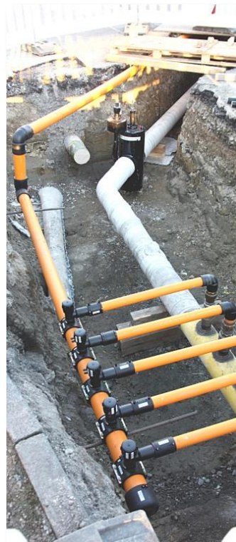
27.02.: Neue Gasleitung ums Eck mit aktivem Bypass während den Verlegearbeiten
