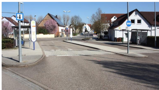
Die sanierungsbedürftige Haltestelle am 06.04.2018
